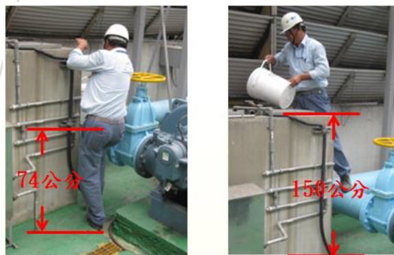
圖 14. 攀爬水管及傾倒原料
