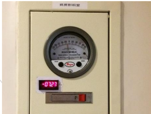
圖 5. 以英寸水柱為單位的指針式氣壓表，與以帕斯卡為單位的數字式氣壓表並列於控制盤
