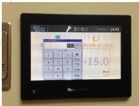
圖 10. 新型介面標示標準氣壓值供人員設定參考
