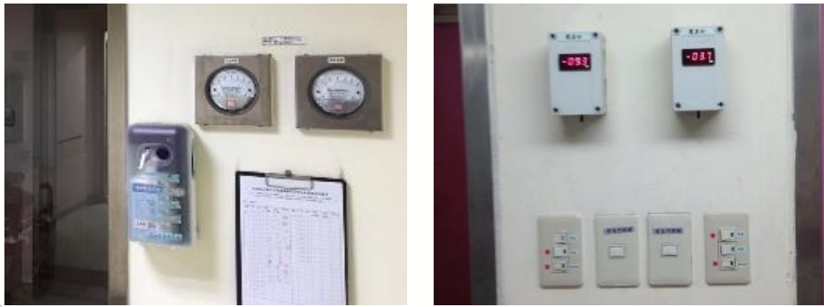
圖 1. 負壓隔離病房所採用之(a)指針式；(b)數字式空調介面（本研究整理）
